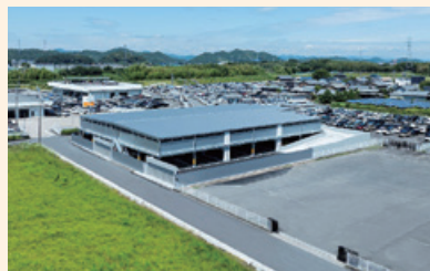
トヨタカラローラネット岐阜 トータルサポートセンター立体駐車場
