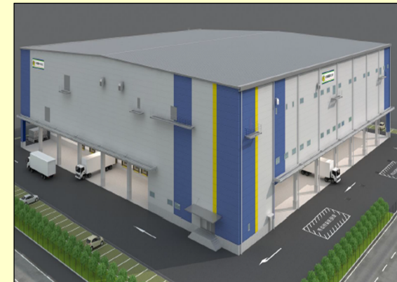
● 関東運輸 狭山物流センター 2018年9月30日 竣工
